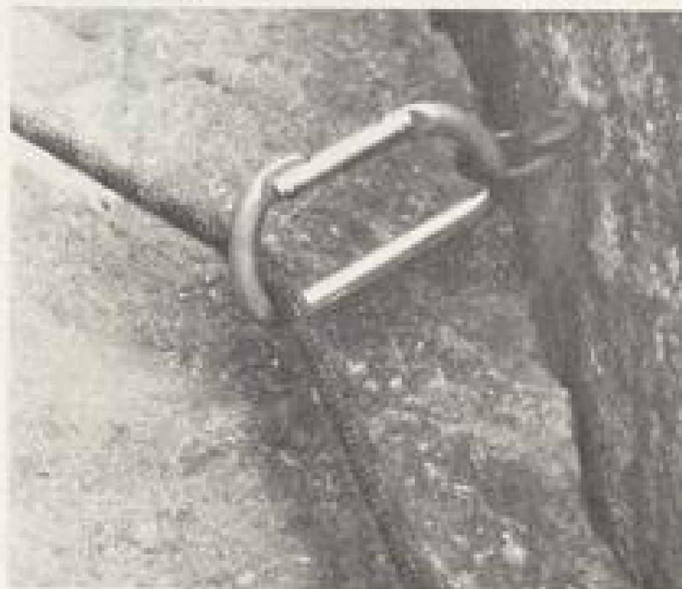
Versichert von der Sicherheit, die zementierte Haken im Klettergarten vermitteln (oben: Marke Böhler), sind alpin unerfahrene Kletterer leicht verführt, zu großes Vertrauen auch in andere Haken zu setzen, die sie im Fels vorfinden. Foto: H. Mögeldorf
