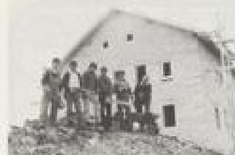
Der Rohbau der Neuen Zeichener Hütte im Juni 1982. Inzwischen ist das Haus nahezu fertiggestellt.
